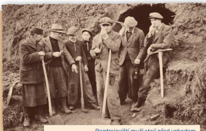
Rozdrojovičtí muži stojí před vchodem do bunkru, který byl vybudován ve válečných letech jako ochrana pro děti ze školy a rodiny bydlící v bezprostřední blízkosti. Nacházel se na konci ulice Cihelna a jeho pozůstatky existují dodnes.
